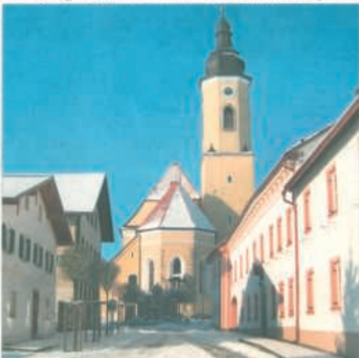
Die Kirche St. Ägidius dominiert als Ankerpunkt die vom historischen Gebäude umgebene „Schloß“ und ist von weither sichtbar. Hier wird die Fassade des Gotteshauses saniert. – Fotos: Haidl
