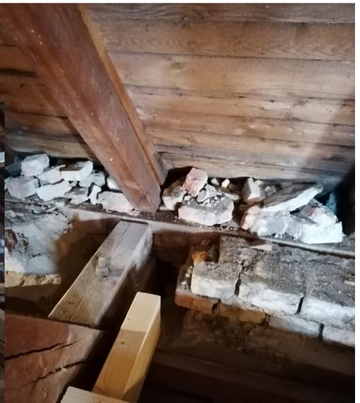
Damit die Balken frei liegen, müssen zwei Ziegelreihen entfernt werden.
