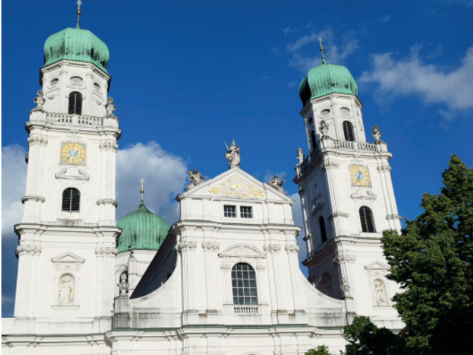
Die Domfassade seit Bischof Rampf mit den Figuren in den Turmnischen und auf dem Giebel
