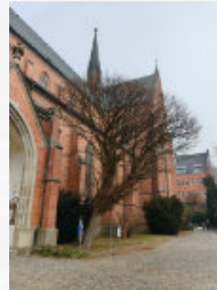
Entfernung der ursprünglich als Zierbäume gepflanzten Akazien. Die unmittelbare Nähe zu Gemäuer und Fundament haben die Dächer verschmutzt, die Feuchtigkeit in die Mauern transportiert und die Wurzeln die Fundamente bedroht. Für die neuen Ringanker der Blitzschutzanlage mussten sie weichen. Die Stadtpfarrkirche präsentiert sich so in neuer Freiheit und beeindruckender Größe.
